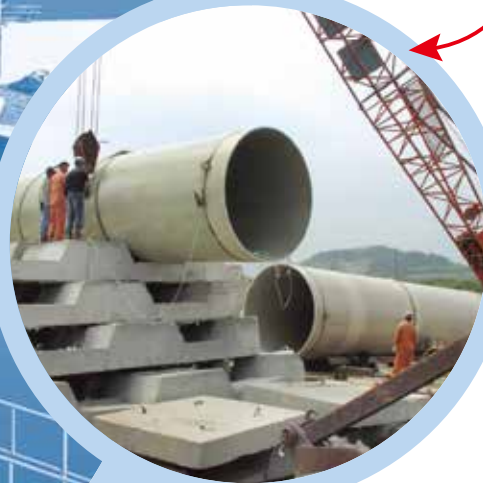
해저 Block 설치 후 상단에 시공
