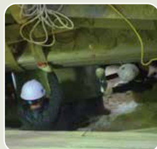
▲ 800A 상수관로 보수공사
