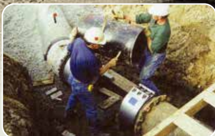
▲ 지하 교체 파이프의 보수공사
