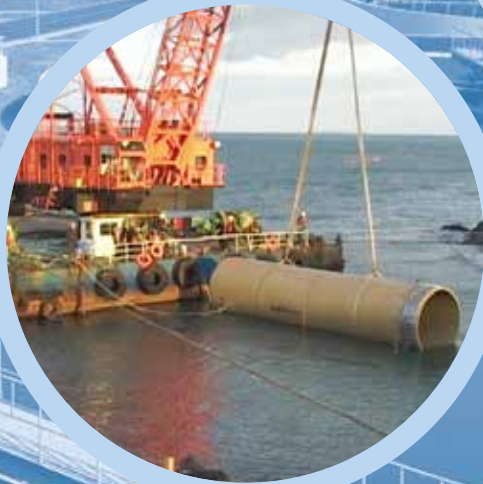
잠수부에 의하여 정확히 설치 후 체결됨
