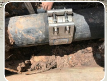
▲PE 파이프 보수공사
