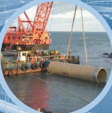
보령화력 발전소 냉각수 배수공사
