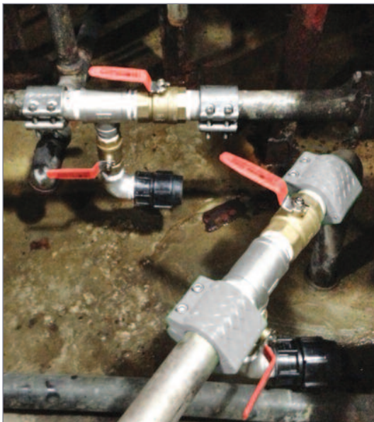
보일러 온수 · 신규밸브 외 파이프 교환수리 완료 (용접이 필요없음)
