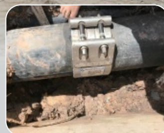
▶ PE Pipe Repair
